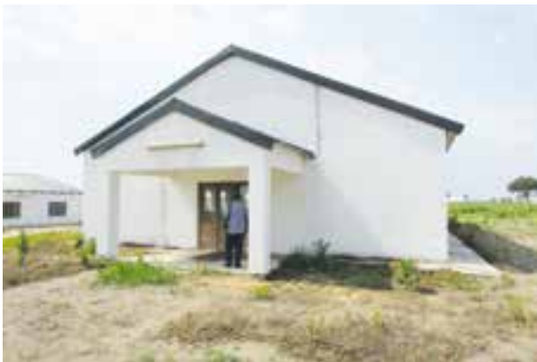
Image 13 : Le camp de travailleurs en construction
