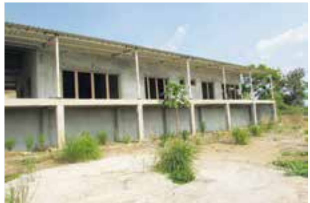
Image 14 : Le Guest House en construction au bord de la rivière Kwango
