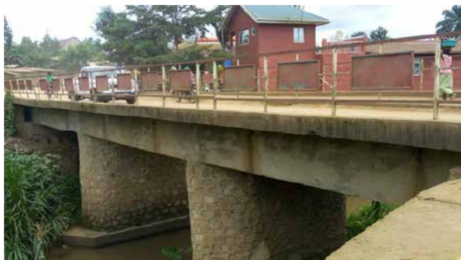
Pont Lokoita. Source : Photo CERV-ORN Bunia. août 2019
