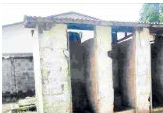
Image 14 : Toilette publique Centre Hospitalier Mont Amba
